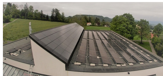
Abbildung 4: Anlage Gallenbühl in Aeugst
