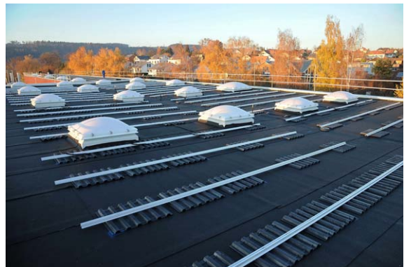
Die Schienen für die Modul-Gestelle liegen bereit
