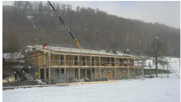
Aufrichten Schrägdach Jonentäli
